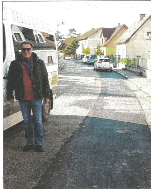
Im Straßenbereich Platte werden neue Wasserleitungen installiert. Bei den alten handelt es sich laut SP-Bürgermeister Gerhard David noch um Bleirohre.
